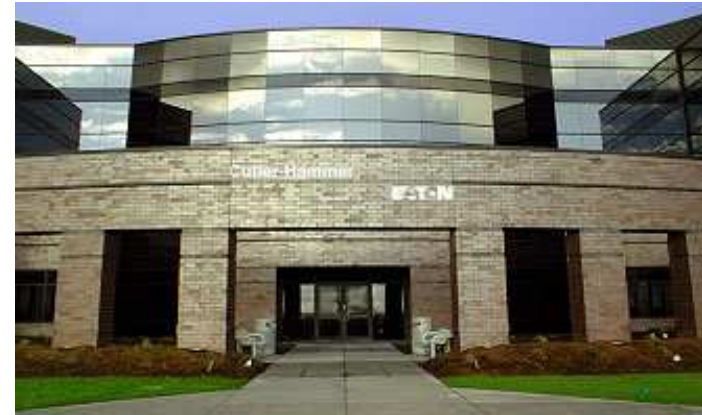
Sede Mundial da Eaton Electrical Pittsburgh, PA – USA
